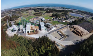
都農・バイオマス発電所(宮崎県湯部郡都農町)
